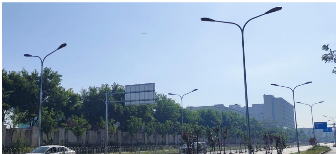
图 3.1-7 照明工程现场照片
