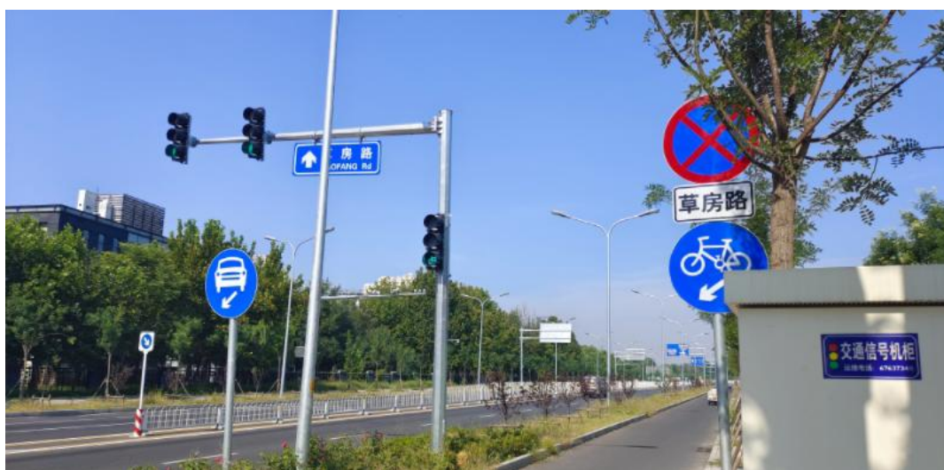
图 3.1-6 交通工程现场照片
