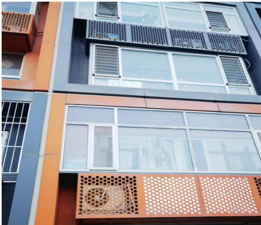
图 7.4-4 中弘北京像素北区 1#楼和中弘北京像素北区 7#楼外窗现状照片
